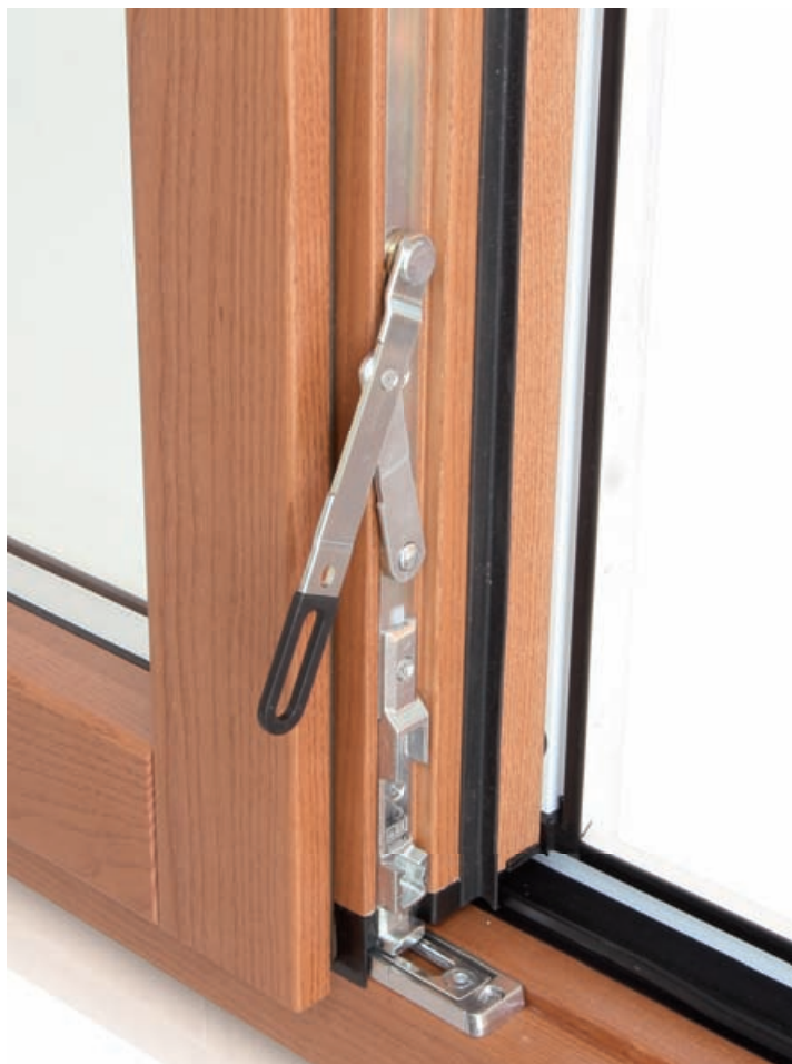
Asta a leva, apertura anta secondaria.
