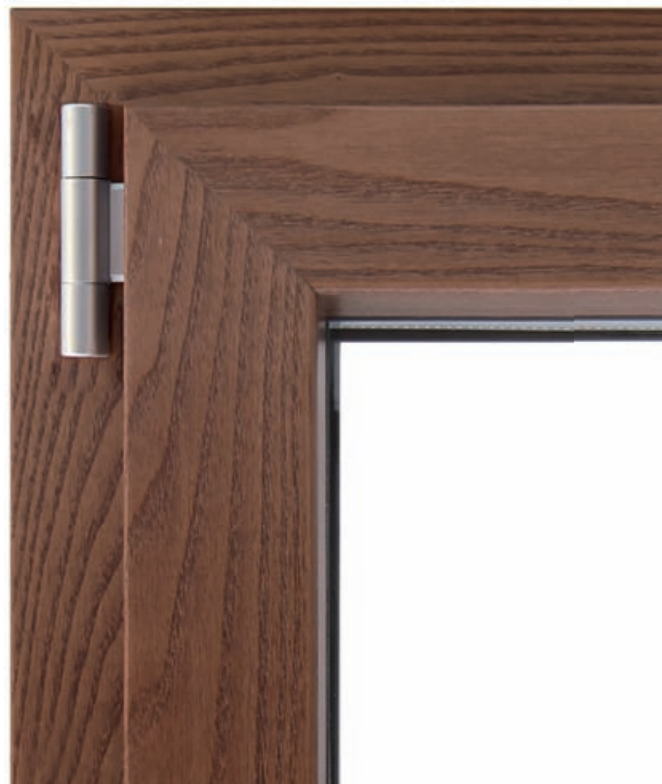
Particolare assemblaggio superiore con taglio a 45°.
