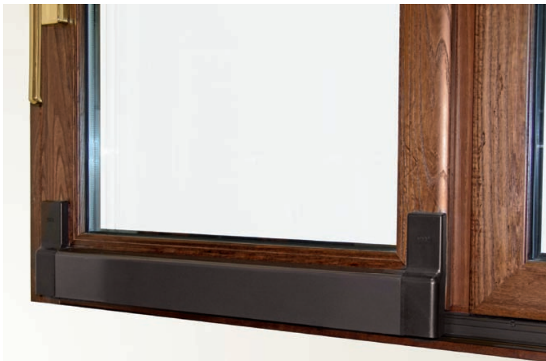
Particolare carter di rivestimento ferramenta scorrevole.
